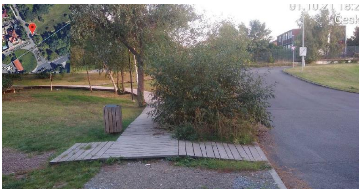
Park Povodňová – pěší trasy zaústěné na komunikace bez hmatových úprav, bez zajištění rozhledových poměrů; zdroj: archiv NIPI
