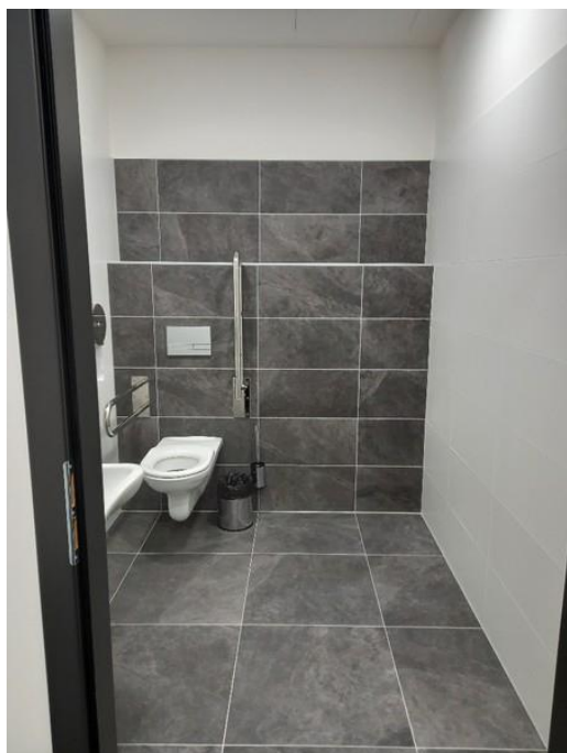
Radnice ÚMČ P12 - Přístupná kabina WC; zdroj: archiv POV
