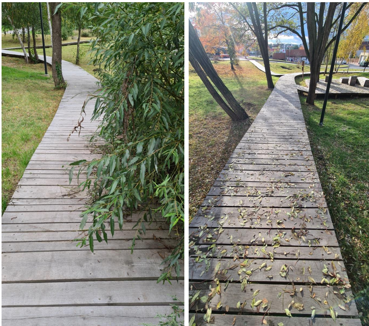
Park Povodňová – podvalový dřevěný chodník, zeď zasahující do chodníku, kluzké listí; zdroj: archiv NRZP ČR
