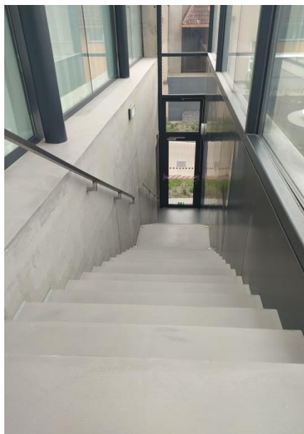
Městská hala Modřice - nebezpečné řešení schodišť, chybějící kontrasty stupňů a chybí madla po obou stranách schodiště; zdroj: archiv NIPI
