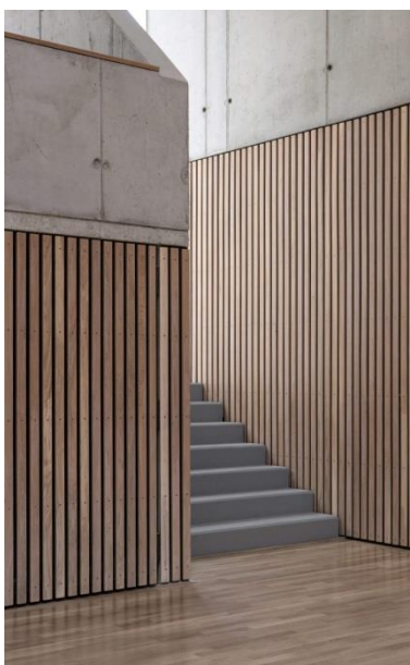
Městská hala Modřice - nebezpečné řešení schodišť, chybějící kontrasty stupňů a chybí madla po obou stranách schodiště; zdroj: archiv NIPI
