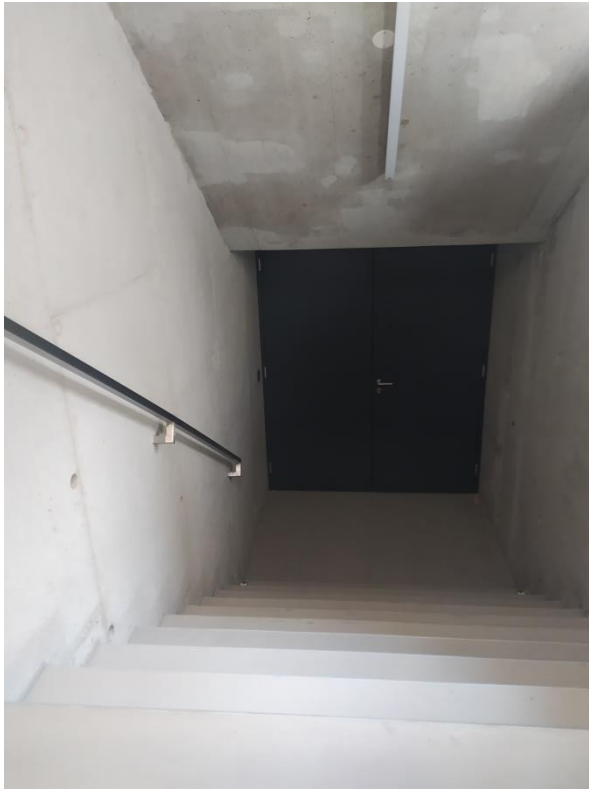
Městská hala Modřice - nebezpečné řešení schodišť, chybějící kontrasty stupňů a chybí madla po obou stranách schodiště; zdroj: archiv NIPI
