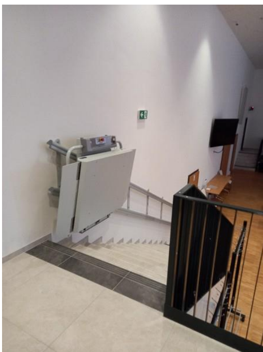
Radnice ÚMČ P12 - Plošina do sálu ve sníženém přízemí
