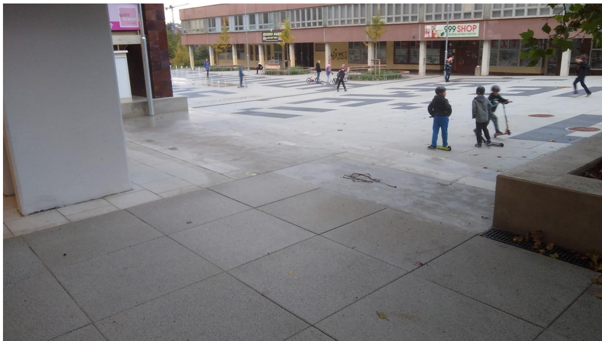
Sofijské náměstí – optický klam (rampa vložená do schodiště bez bezpečnostních prvků); zdroj: archiv NRZP ČR
