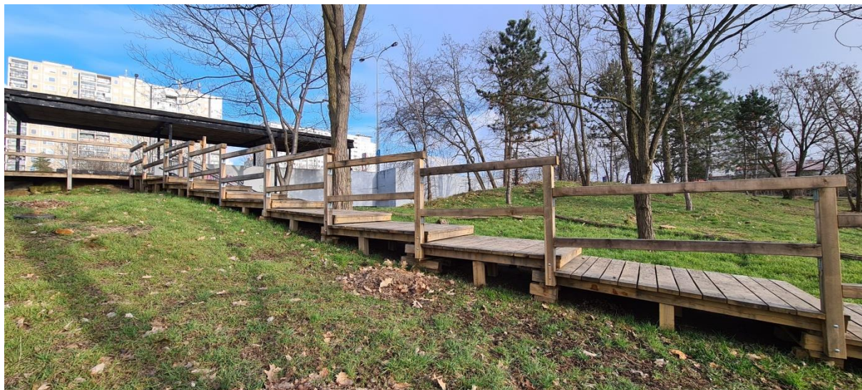
Park Povodňová – jezdecké schody k zastávce veřejné dopravy; zdroj: archiv NRZP ČR
