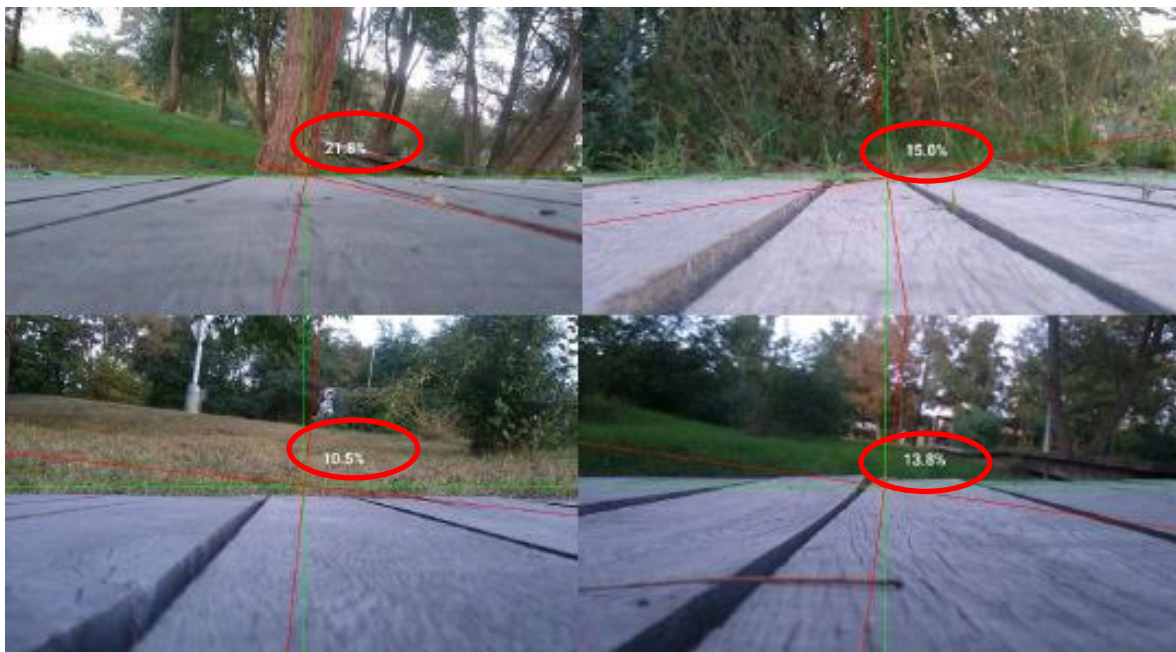
Park Povodňová – příčné sklony dřevěného chodníku; zdroj: archiv NIPI
