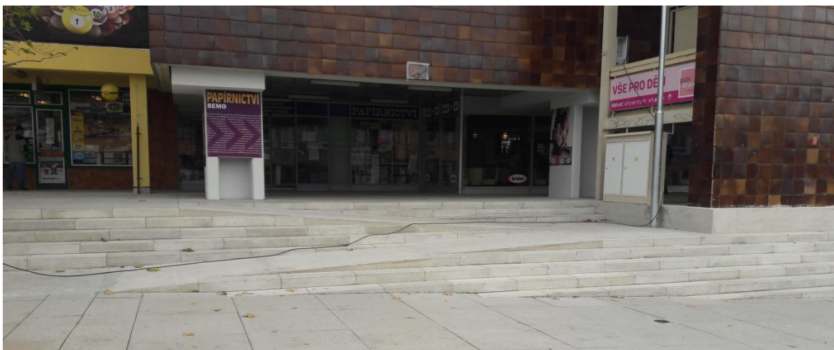
Sofijské náměstí – rampa vložená do schodiště, bez zábradlí, bez madel, bez zarážek proti sjetí, bez kontrastů, umožňuje optický klam a dojem, že pasáž je ve stejné výšce jako náměstí; zdroj: archiv NRZP ČR
