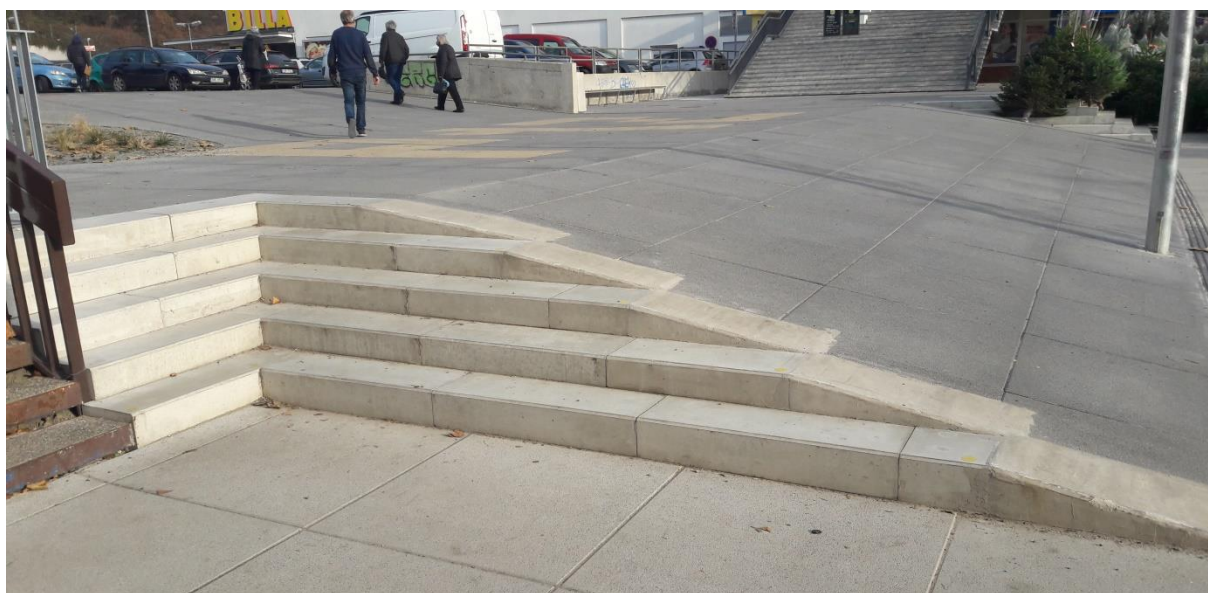
Sofijské náměstí – uskakuující schody bez zábradlí, bez kontrastního zvýraznění; zdroj: archiv NRZP ČR
