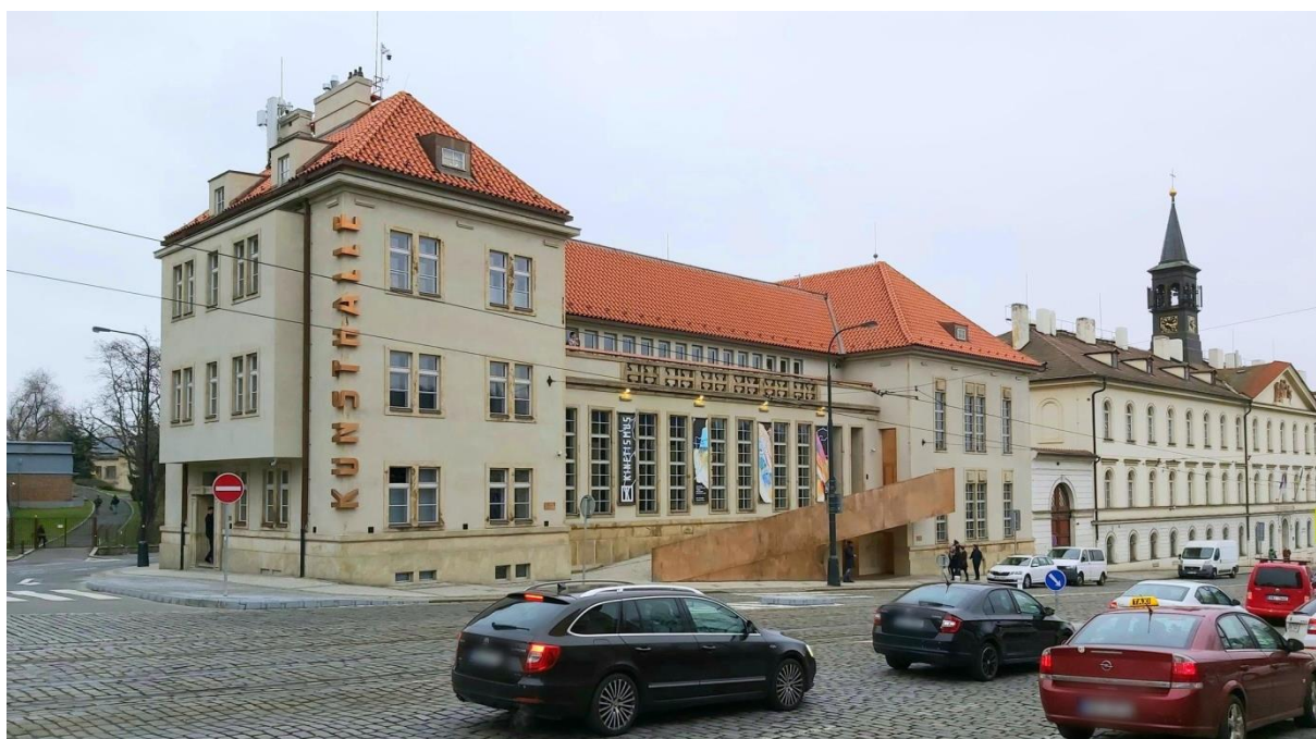
Kunsthalle Praha – úprava Zengerovy transformační stanice na galerii moderního umění; zdroj: mapy.cz
