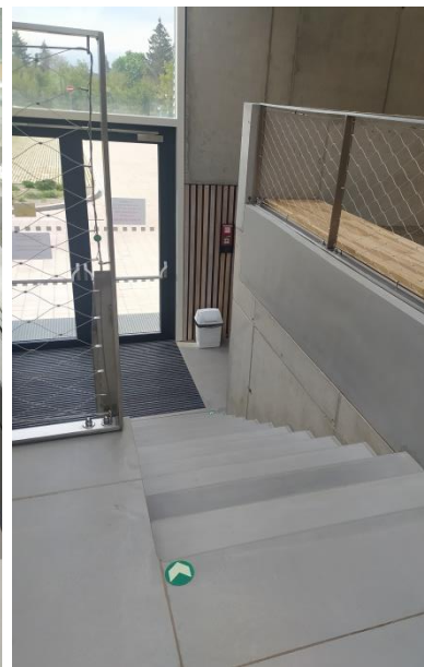
Městská hala Modřice - nebezpečné řešení schodišť, chybějící kontrasty stupňů a chybí madla po obou stranách schodiště; zdroj: archiv NIPI
