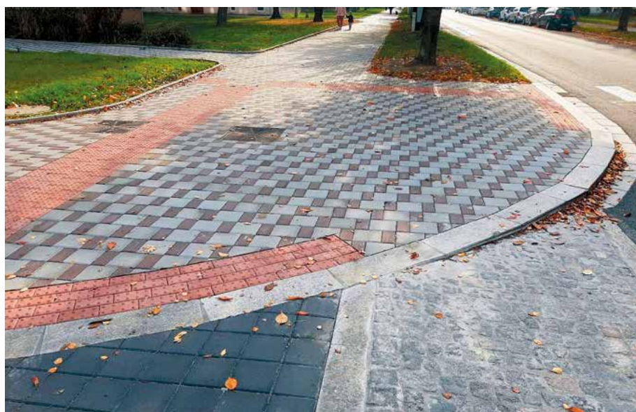
Na největším pardubickém sídlišti neodpovídá předpisům například tento přechod: varovný pás nedosahuje až do výšky obruby + 8 centimetrů.
