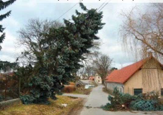
Jednou z častých příčin poruch je strom spadlý do vedení
