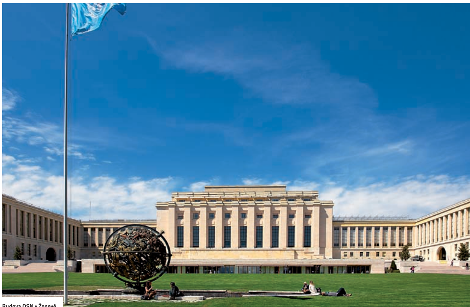
Budova OSN v Ženevě
